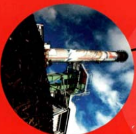
VILLENEUVE Combustibles : fioul, bois, charbon Fonctionne en hiver
